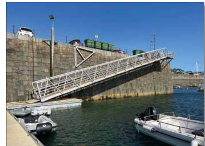
Tidenhub anschaulich: Kaum zu glauben, aber die Rampe ist bei Hochwasser fast waagrecht
