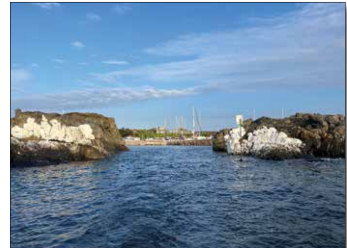
Besondere Hafeneinfahrt. Ein ehemaliger Steinbruch dient hier als Hafenbecken. Die Einfahrt wurde in den Felsen gesprengt. Eine „Sill“ – in diesem Fall keine Mauer, sondern die Felsenunterkante – hält den Wasserstand bei Niedrigwasser im Hafenbecken. Das „Ein- und Ausfahrtszeitfenster“ wird per Gezeitenkurve für den Tag vorausberechnet.
